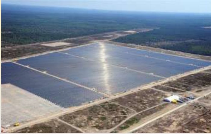
Lieberose, Allemagne, 53 MW, 2009, 53 GWh, CdTe fixes
