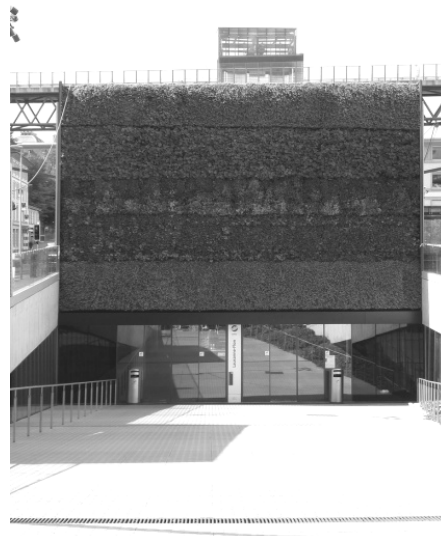
Mur Façade Est (largeur : 12,608 m)
