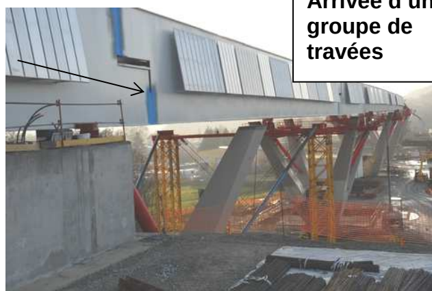
Zone de liaison des travées par soudure
