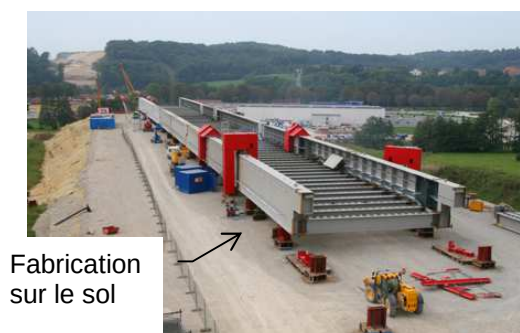
Zone de liaison des travées par soudure
